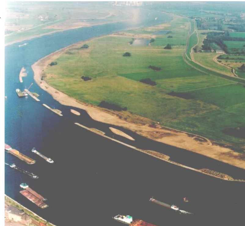
Parallelwerk Walsum-Stap, Rijn km 793,5 – 795. Wasser- und Schifffahrtsverwaltung des Bundes, Wasser- und Schifffahrtsdirection West
