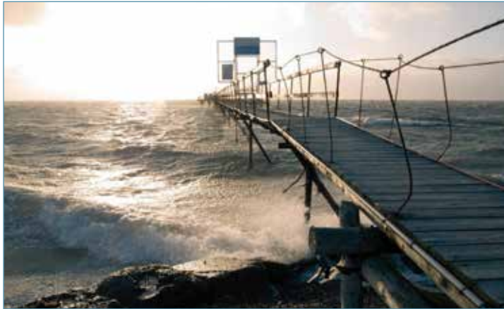
Nissum Bredning Test site
